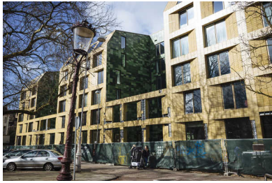
→ De gevel van Hyatt Regency aan de kant van de Singelgracht.
